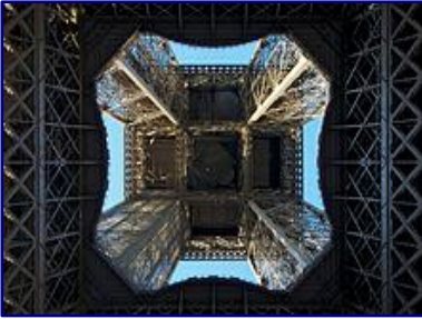
Le premier étage depuis la base
