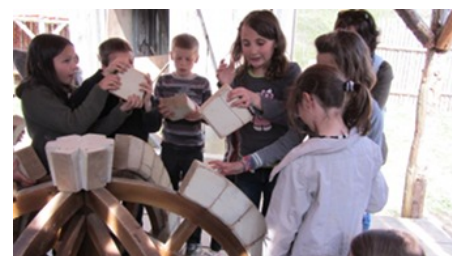
Killian, Maxime et Aurore mettent les pierres sur le gabarit pour monter la voûte.
