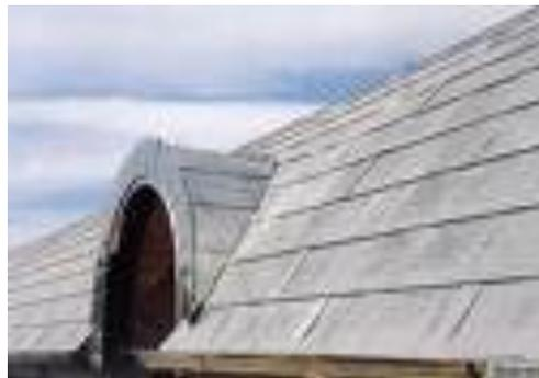
Le métal zinc résiste à la corrosion. Exposé à l'air il se recouvre d'une couche protectrice blanchâtre.
