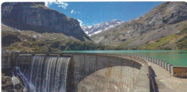
Doc. 1 Barrage hydroélectrique
