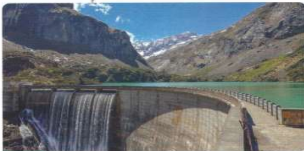
Doc. 1 Barrage hydroélectrique
