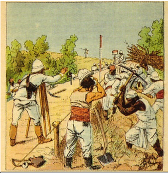
Construction d'une route à Madagascar
