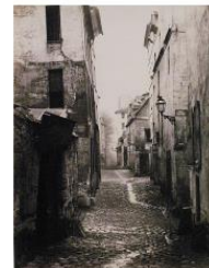
Le boulevard Henri IV à Paris, avant et après les travaux d'Haussmann
