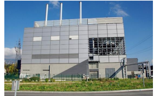
Usine de traitement des déchets.
