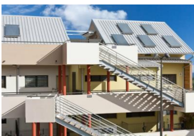
Panneaux chauffe-eau solaires sur le toit d'un immeuble.
