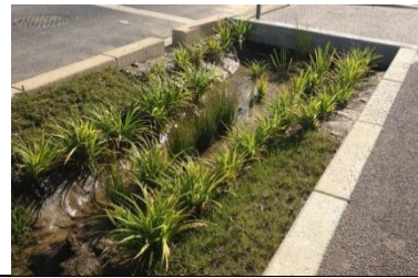
Infiltrations des eaux de pluie, noues écoquartier du Raquet.
