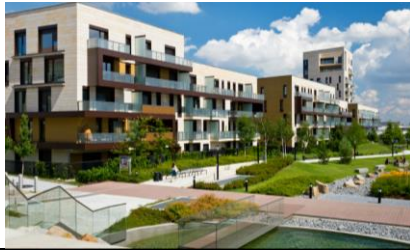
Immeubles d'un écoquartier avec un cours d'eau.
