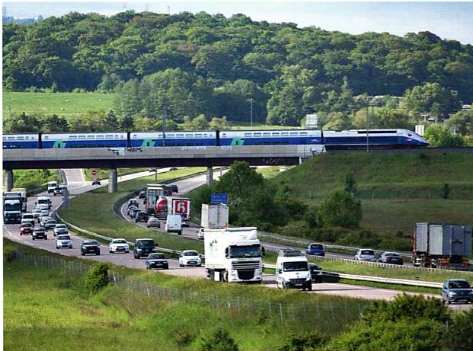
Photographie de l'autoroute A31, en Meurthe-et-Moselle.
