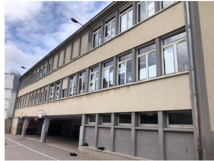
Bâtiment B (les classes de CP sont au 1 er étage)
