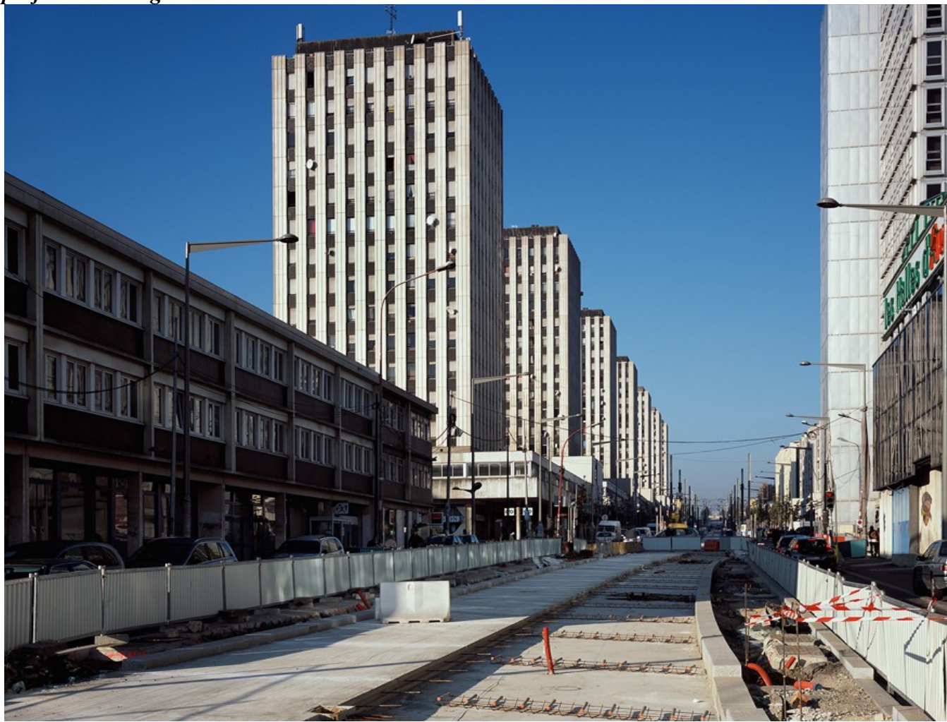
Construction du T5, reliant Saint-Denis à Sarcelles (mise en service en juin 2013)
