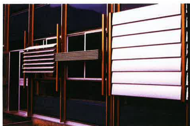
Mur-rideau de la cité scolaire de la Dulague, Béziers, 1962
