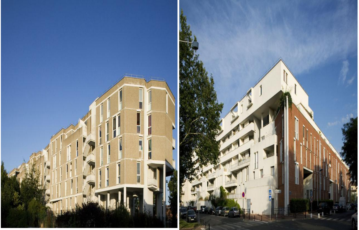
© Hugues Desmichelle L'ensemble du bâtiment dispose d'un jardin intérieur au cœur du triangle.
