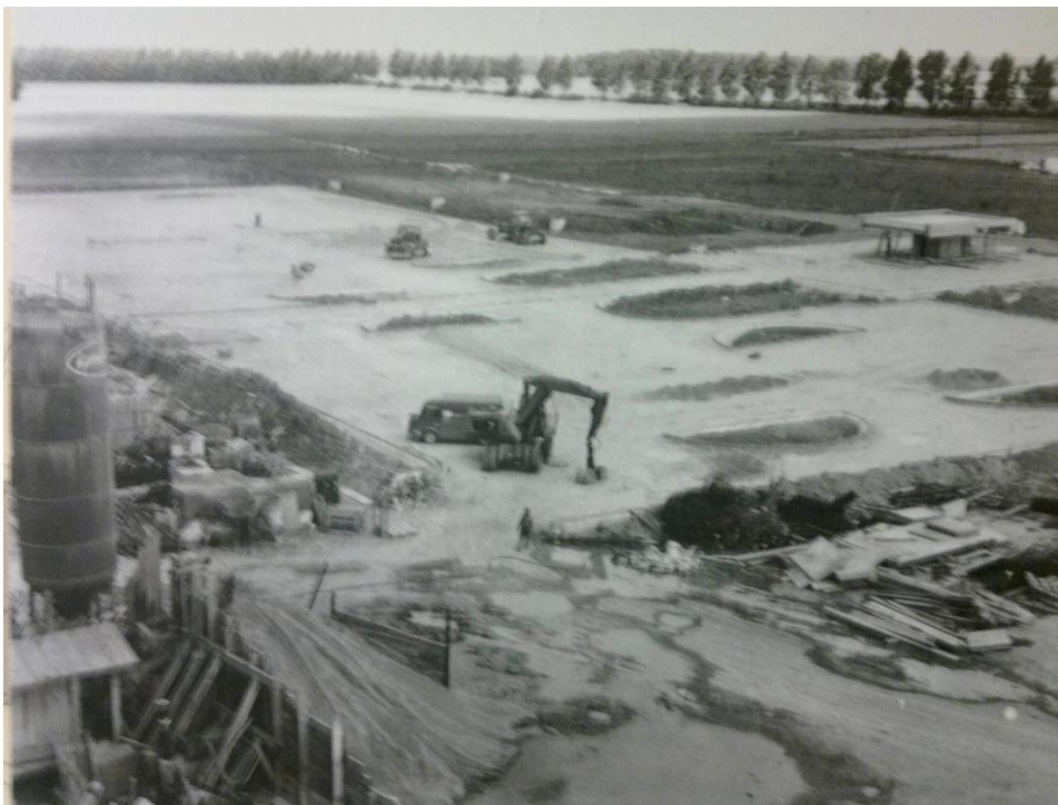
Aménagement du parking de la préfecture
