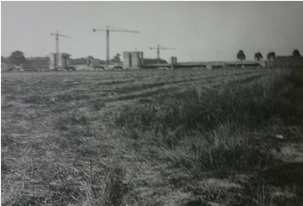
Début du chantier de construction de la Préfecture
