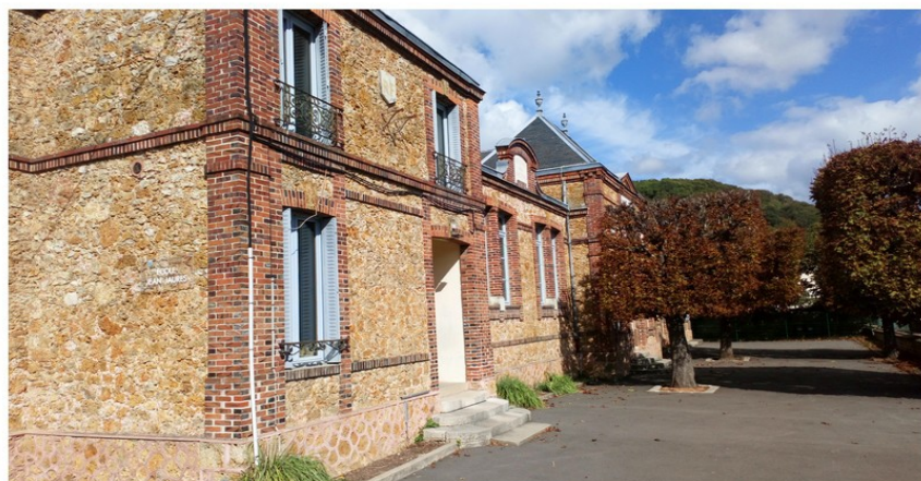
Bâtiment C Vieux Jaurès
