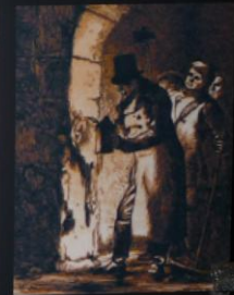
Bruneseau descendant en égout Bruneseau going down into a sewer
