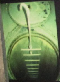
L'égout accède à l'égout par un fondement de regard fermé par un couvercle en fer. L'égout est un tuyau en béton qui descend de votre maison jusqu'au collecteur.
