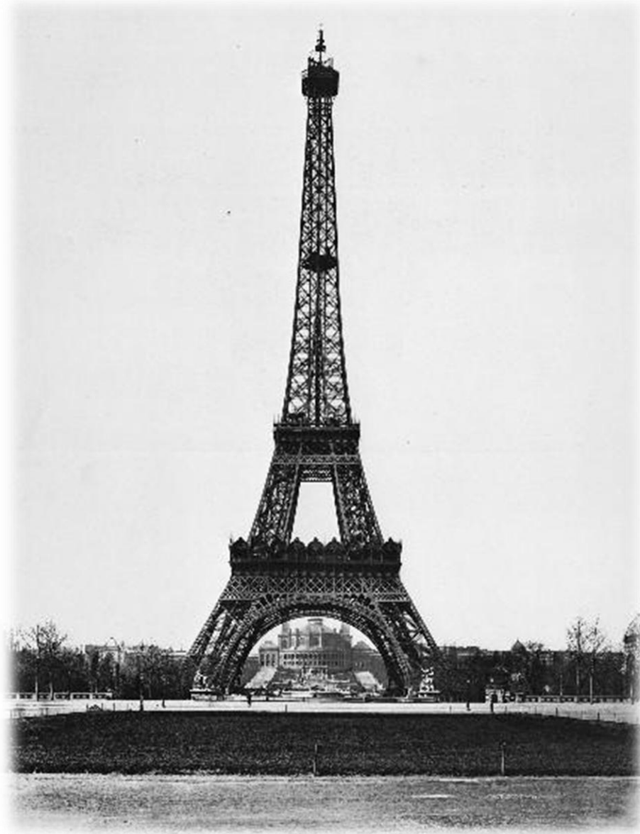
Vue générale de l'ouvrage achevé
