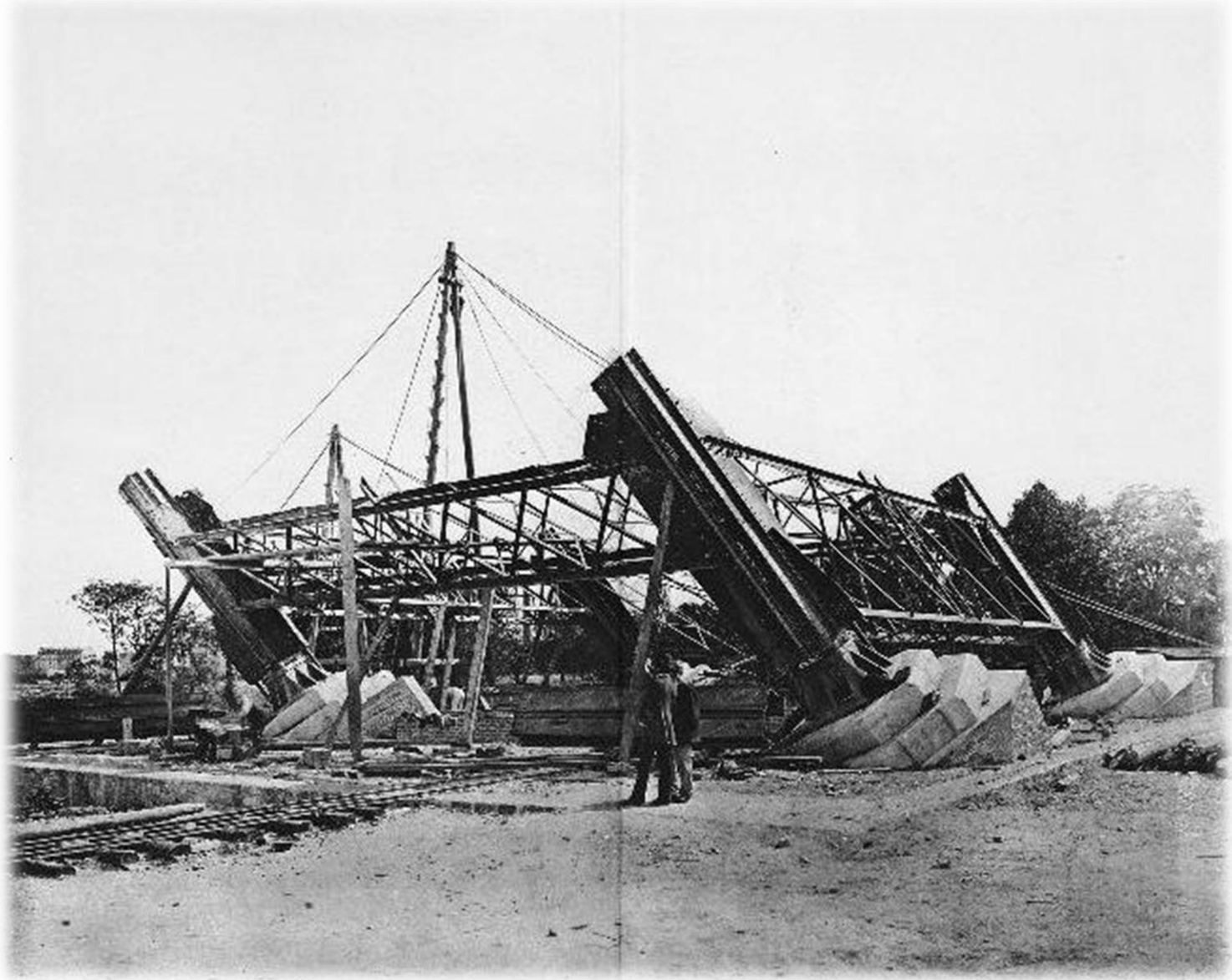
Commencement du montage métallique de la pile n°4
