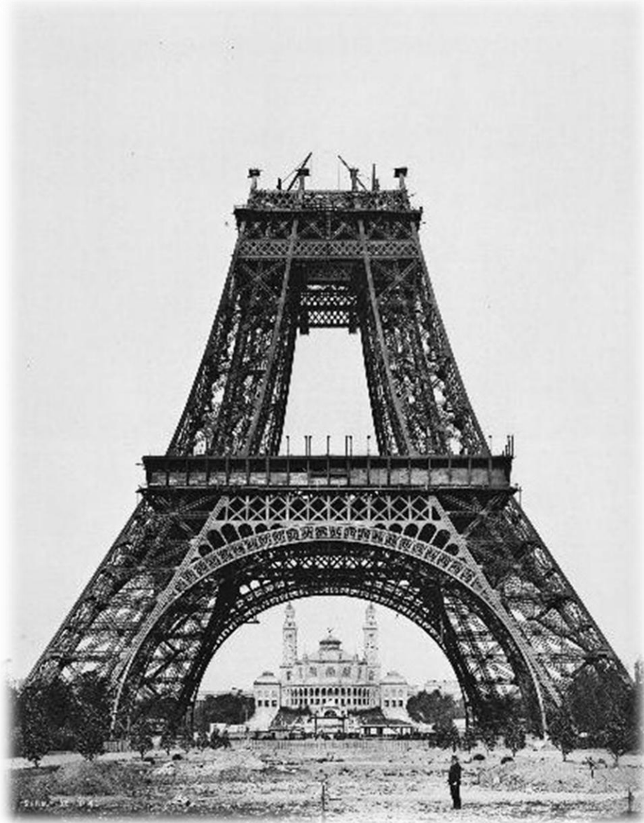
Montage de la 2 ème plateforme
