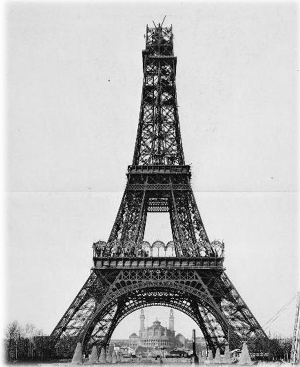
Montage de la partie supérieure
