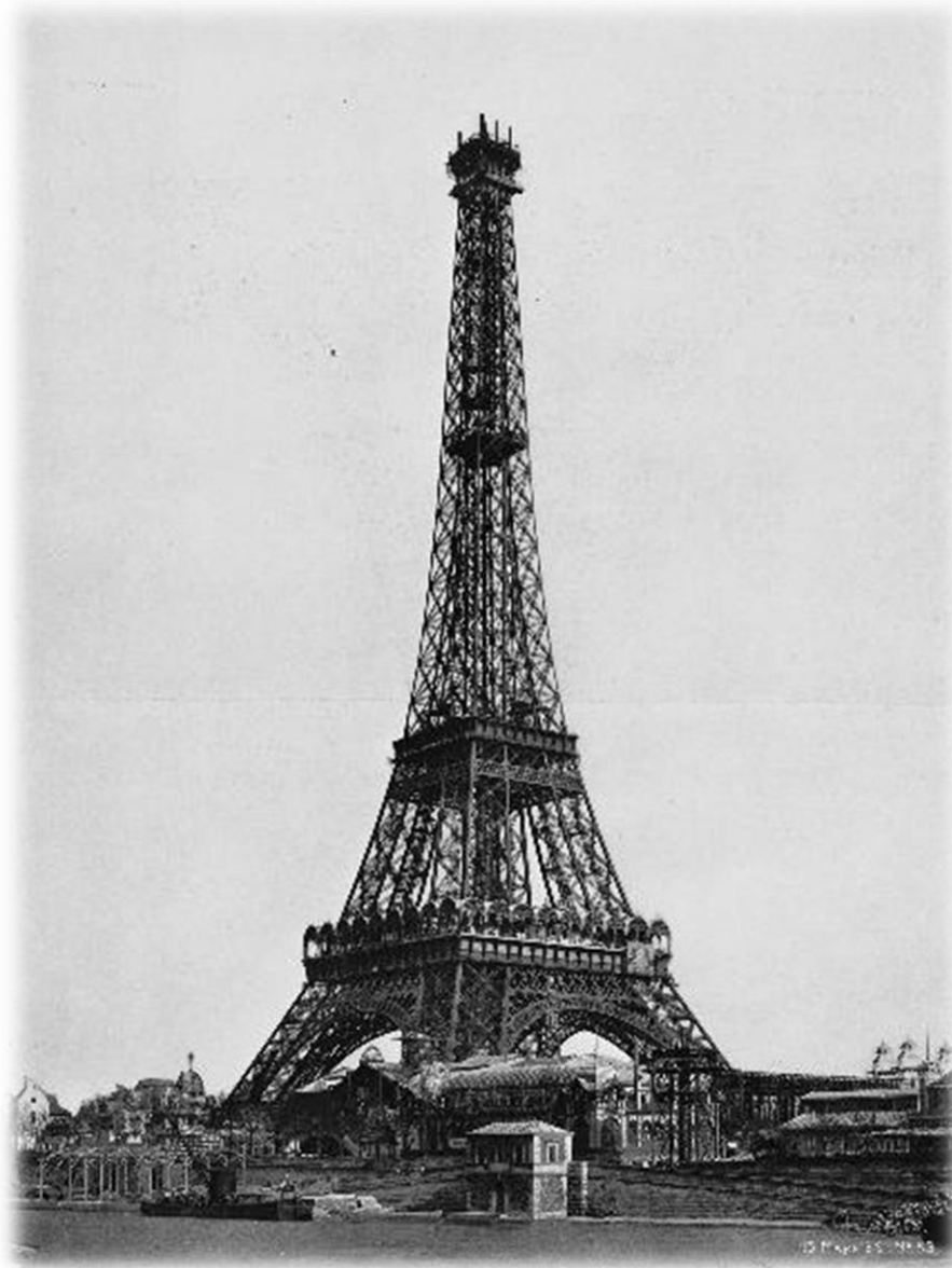
Montage du campanile
