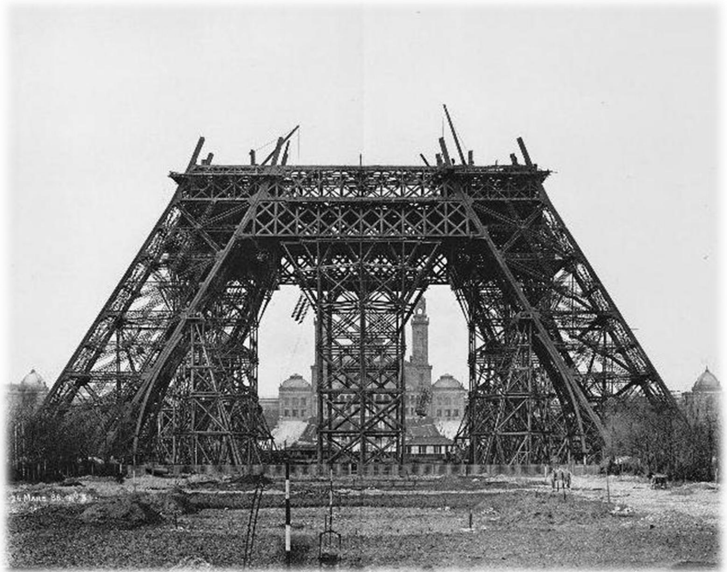
Montage des poutres horizontales sur l'échafaudage du milieu
