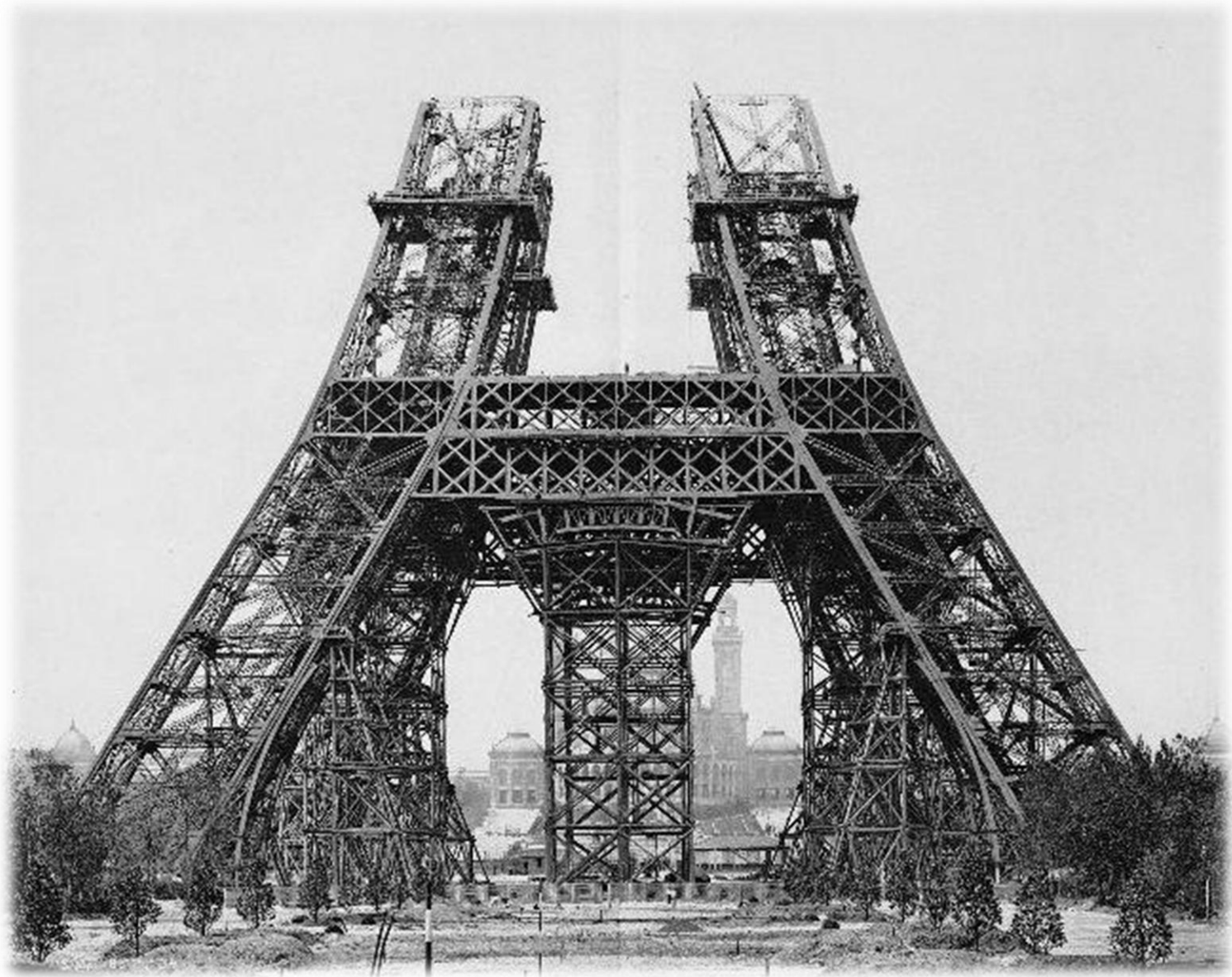
Montage des piliers au-dessus du premier étage
