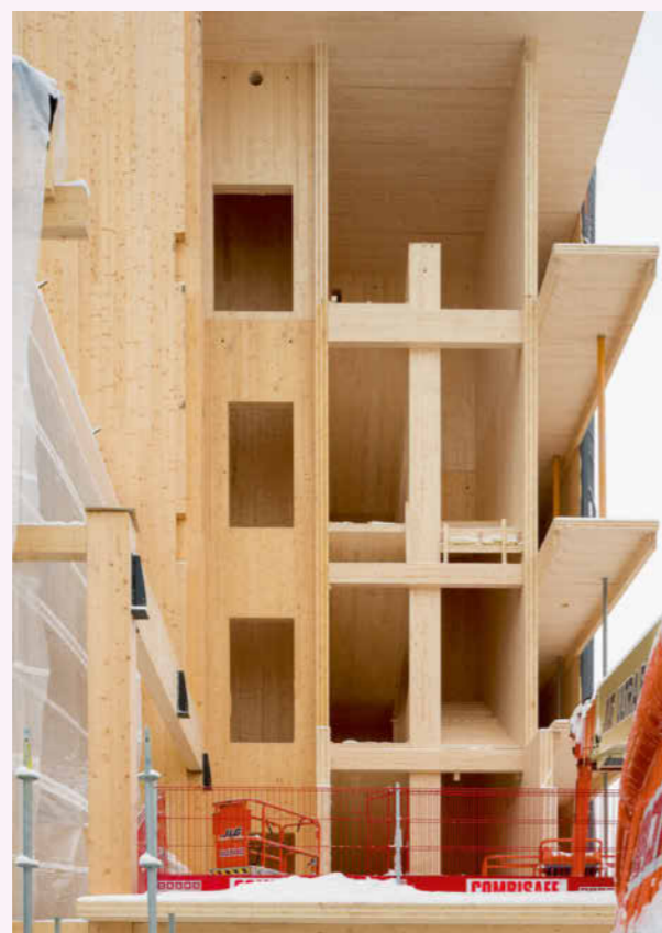
Même les parties cachées soutenant l'immeuble sont en bois (ici, pendant la construction). ©Martinsons-Jonas Westling
