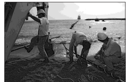
Doc.4 Posé d'un réseau de câbles sous-marins reliant la France à Singapour et l'Algérie.
