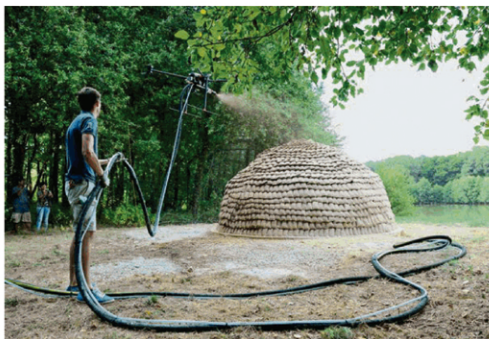
Pour l'atelier consacré aux architectures de terre qui s'est déroulé en août, un drone pulvérise de l'argile sur un abri. CIRECA/DOMAINE DE BOISBUCHE
